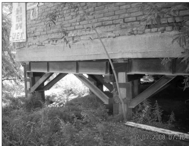
Рис. 1. Свайные фундаменты в г. Якутске. Фото С.И. Серикова
