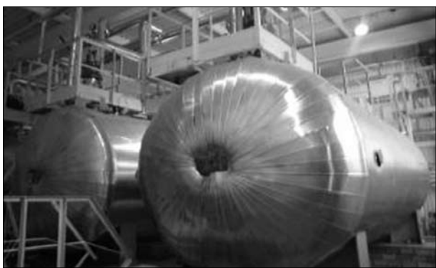
Помещение приготовления щелочи
