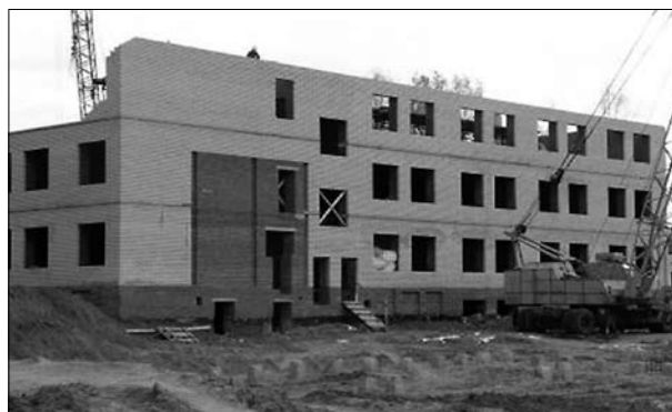
Строительство Дома культуры в п. Кизнер
