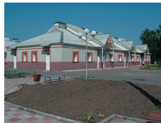
Реконструкция инфекционного отделения ЦРБ (г. Почеп, Брянская область)
